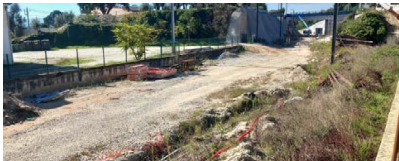
Linha da Beira Alta (Nelas): estado da obra em Setembro de 2023
